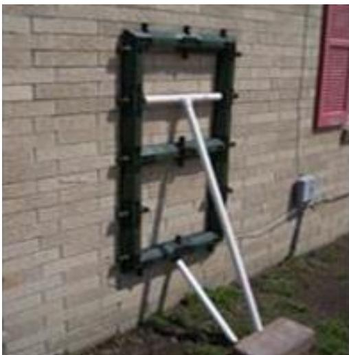
Fig. 39. Découpage d'orifice dans le mur à l'aide des ceintures explosives.
