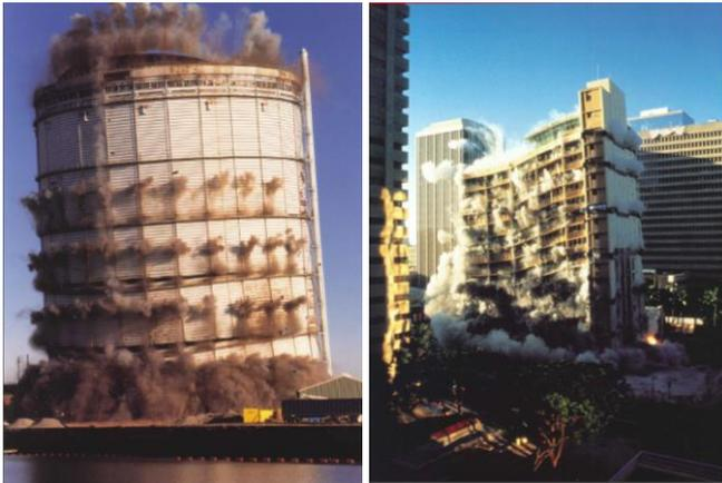
**Fig. 36. Démolition contrôlée du grand réservoir (à gauche) et du bâtiment tour (à droite). Les charges explosives particulières sont mises à feu selon la séquence temporaire conçue précisément [24].**
